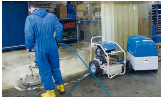
350 bar et de l'eau chaude lors des travaux de nettoyage d'un sol d'atelier
